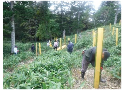
保護管設置の様子
