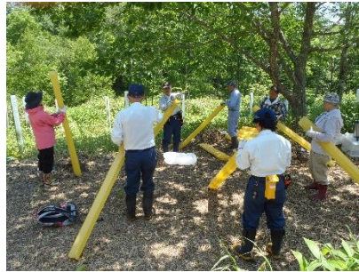
保護管組立ての様子
